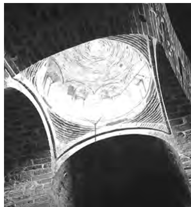
Εἰκ. 4. Ἀριστερά τὸ Καθολικὸν τῆς Ἱ. Μ. Ὁσίου Λουκᾶ στὴν Βοιωτία. Δεξιά ὁ Ἱ. Ναὸς τῆς Παναγίας τοῦ 10 ου αἰῶνα ὅπου, ἀκόμα καὶ τὰ ἴχνη τῶν ξύλινων ἐλκυστήρων – θλιπτήρων ἔχουν ἐπιμελῶς ἀφαιρεθεῖ κατὰ τὶς ἐπισκευές τοῦ 2 ου μισοῦ τοῦ 20 ου αἰῶνα.
