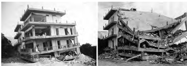
Εικ. 11. Ἀριστερά: Νεόδμητο, ἀδειοδοτημένο, σχεδόν τελειωμένο, μὴ κατοικούμενο ἀκόμα κτίριο στό Λουτράκι κατεστραμμένο κατὰ τόν σεισμό τοῦ 1981. Δεξιά: Νεόδμητο, ἀδειοδοτημένο, σχεδόν τελειωμένο, μὴ κατοικούμενο ἀκόμα κτίριο στήν Ἀθήνα κατεστραμμένο κατὰ τόν σεισμό τοῦ 1999.
