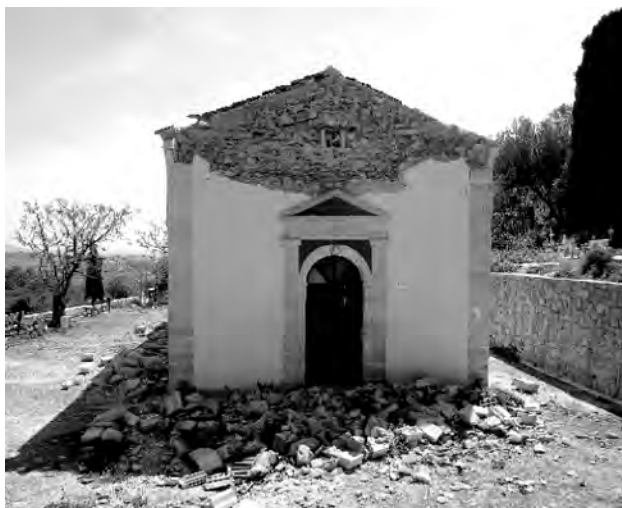
Σχῆμα 10. Άστοχία τοπικοῦ μηχανισμοῦ ἀνατροπῆς ἐξωτερικῆς στρώσης τυμπάνου ἀετώματος: α) φωτογραφικὴ ἀποτύπωση, β) σχηματικὴ ἀναπαράσταση.
