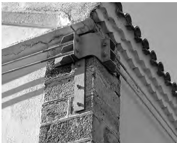
Σχήμα 4. Τοποθέτηση έλκυστήρων υπό τη μορφή περιμετρικής περιδσεσης στους περιμετρικούς τοίχους.
