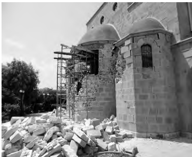
Σχήμα 9. Τοπικός μηχανισμός άνατροπής της κόγχης: (α) φωτογραφική αποτύπωση, (β) σχηματική αναπαράσταση.
