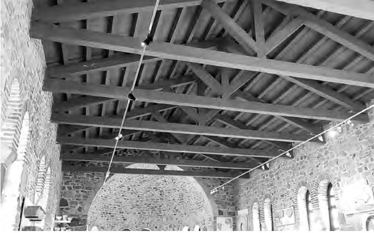
Εἰκ. 3. Ἡ στέγαση τῆς Τράπεζας τῆς Ἱ. Μ. Ὁσίου Λουκᾶ ἀπὸ ὀπλισμένο σκυρόδεμα σὲ ἀπομίμηση τυπικοῦ ξύλινου φορέα.
