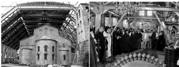
Εἰκ. 7. Τό Πρωτάτον (ἀρχές 10ου αἰ.) τοῦ Ἀγίου Ὁρους μέ τό προστατευτικό μεταλλικό κάλυμμα, μέσα καί ἔξω τοῦ μνημείου, γιά τίς ἐργασίες ἀποκατάστασης τῆς στέγας.
