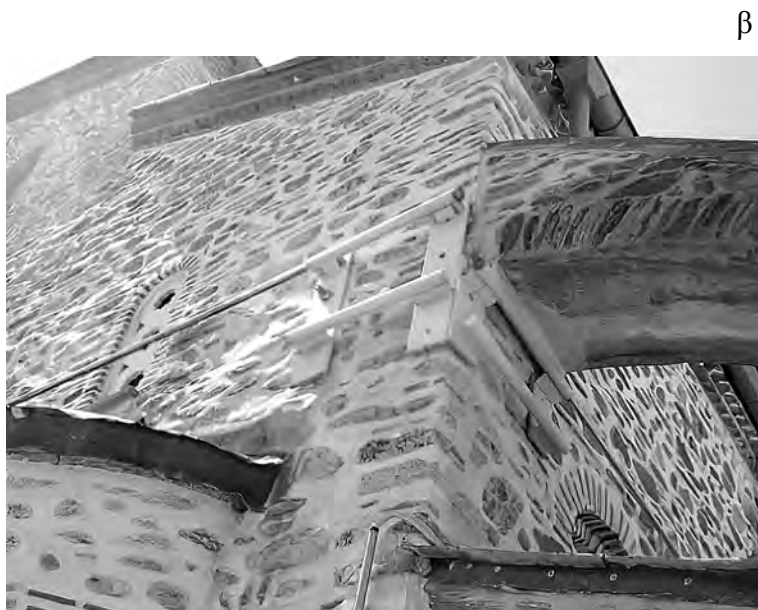
Σχήμα 4. Τοποθέτηση έλκυστήρων υπό τη μορφή περιμετρικής περιδσεσης στους περιμετρικούς τοίχους.
