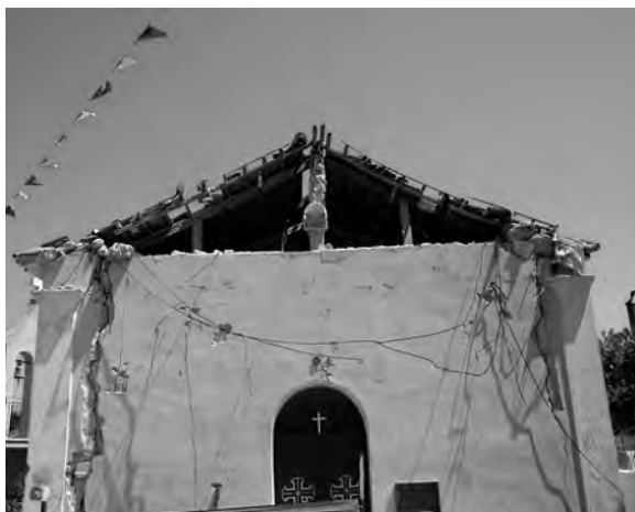
Σχῆμα 11. Ἀστοχία τοπικοῦ μηχανισμοῦ ἀνατροπῆς τυμπάνου ἀετώματος καί ἔναρξη ἀνάπτυξης τοπικοῦ μηχανισμοῦ ἀνατροπῆς δυτικῆς ὀψης: α) φωτογραφική ἀποτύπωση, β) σχηματική ἀναπαράσταση.
