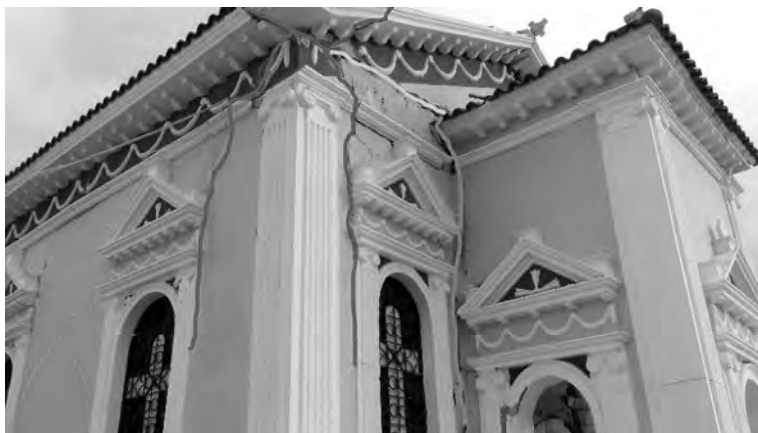
Σχῆμα 1. Συνδυασμένη μορφή άστοχίας λόγω τόσο τῆς συμπεριφοράς τῆς κατασκευῆς «ὡς συνόλου» ὅσο καὶ τῆς ἐνεργοποίησης τοπικῶν μηχανισμῶν.
