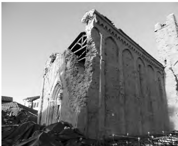
Σχήμα 8. Τοπικός μηχανισμός άνατροπής εκτός επιπέδου: α) φωτογραφική αποτύπωση, β) σχηματική αναπαράσταση.
