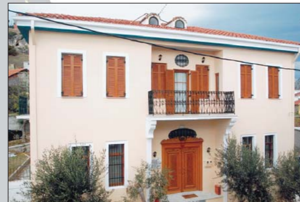
Ὁλοκληρώθηκαν πρόσφατα οἱ ἐργασίες ἀνακαίνισης τοῦ Ἐπισκοπεῖου τῆς Ἱ. Μητροπόλεως Σιδηροκάστρου.
