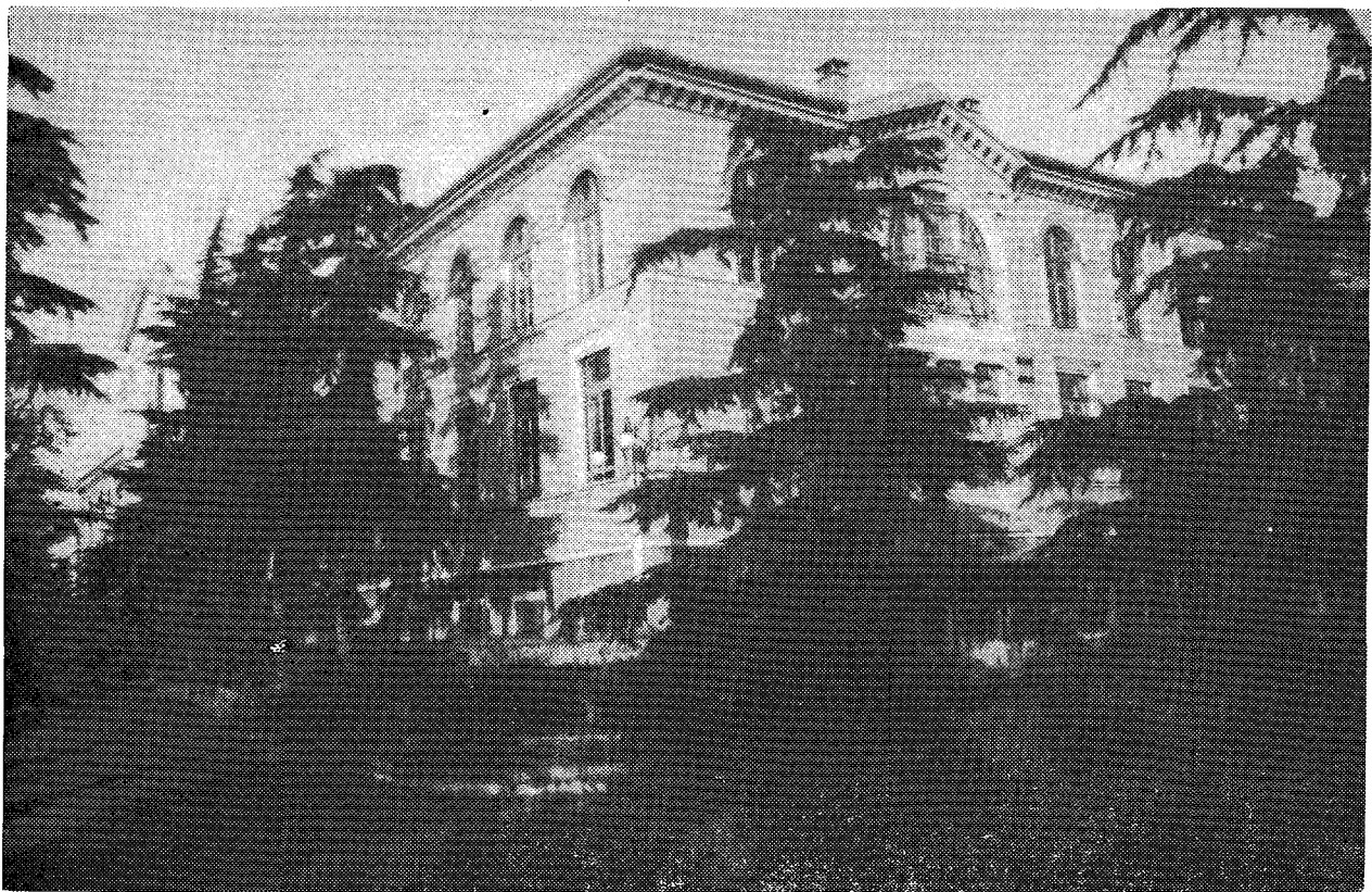
Μερικὴ ὄψις τῆς νοτιοδυτικῆς πλευρᾶς τοῦ κτηρίου τῆς Σχολῆς καὶ ὁ γραφικὸς δρόμος (διάδρομος), ὁ ὁποῖος ὀδηγεῖ εἰς τὴν κεντρικὴν αὐτῆς εἴσοδον.
