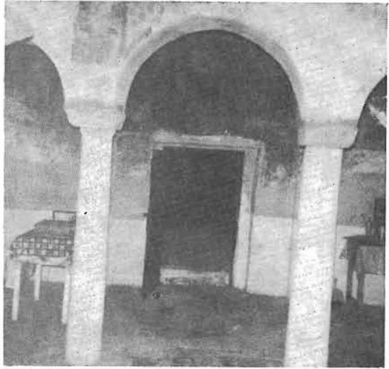
Εικ. 7. Ἡ εἴσοδος τοῦ Ναοῦ ἐσωτερικῶς καὶ οἱ δύο κίονες οἱ σχηματίζοντες τρίβηλον.
